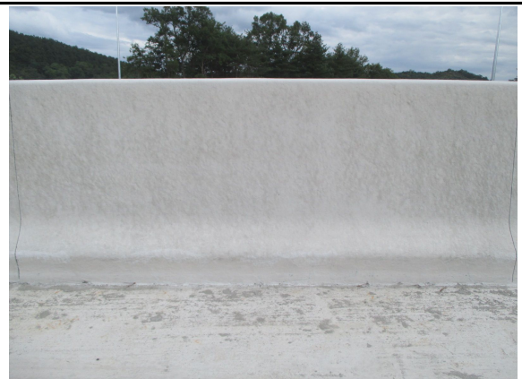
방호벽 시공 상태 점검
