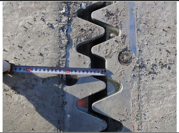
신축이음 A1 유간 측정
