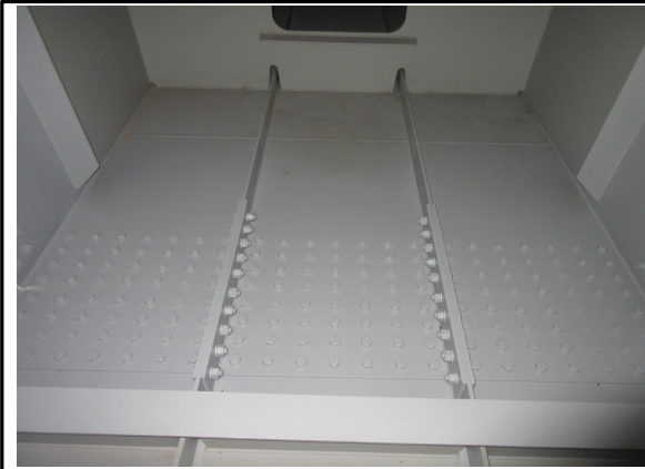
BOX 내부 시공 상태 점검
