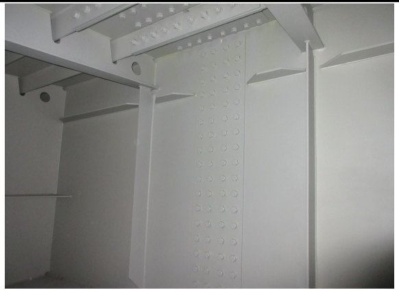
BOX 내부 시공 상태 점검
