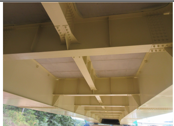
슬래브 하부 전경
