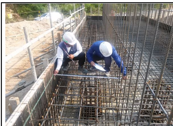
A2 기초 철근 배근 간격 측정
