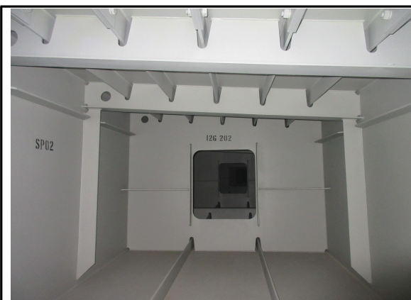
BOX 내부 시공 상태 점검
