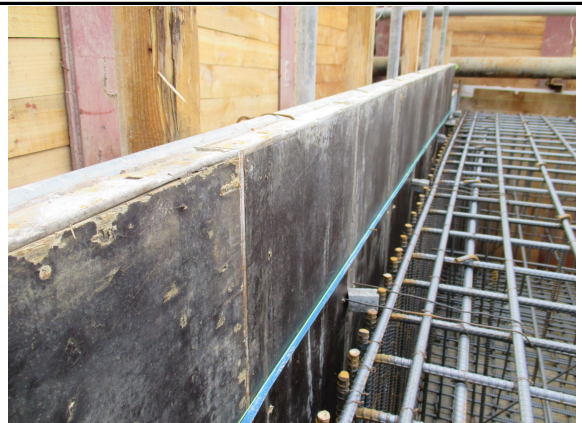
P2 기초 거푸집 상태 양호
