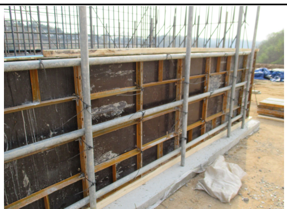
A2 거푸집 상태 양호
