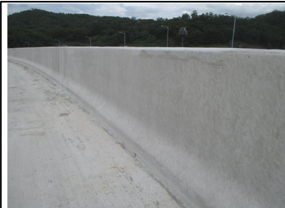
방호벽 시공 상태 점검
