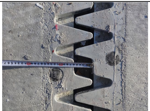
신축이음 A2 유간 측정
