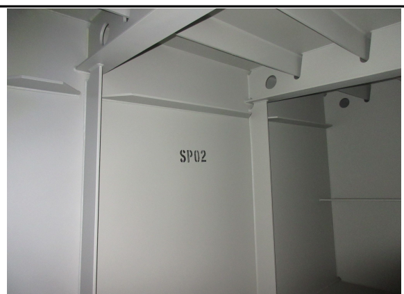
BOX 내부 시공 상태 점검
