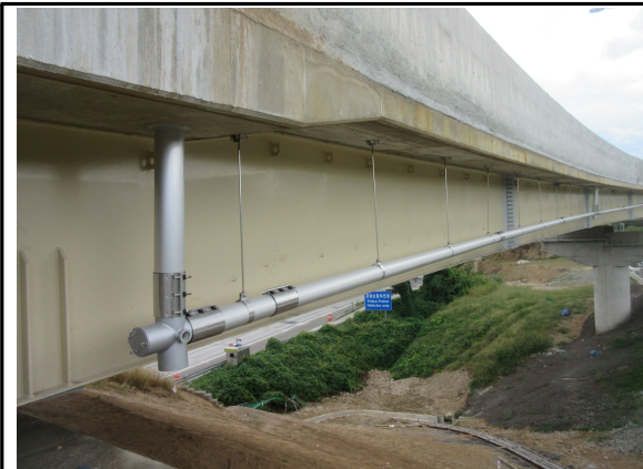
배수관 시공 상태 점검
