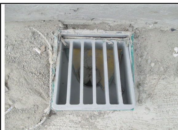
배수구 시공 상태 전경(완료전)
