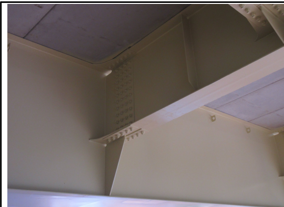
BOX 외부 시공 상태 점검
