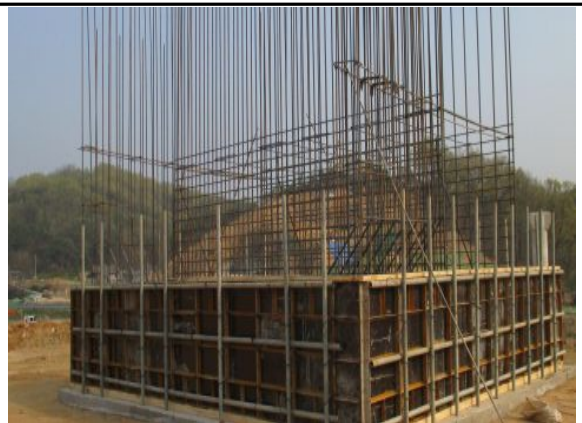
A2 기초 시공 상태 점검
