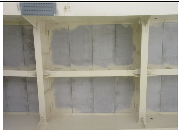
바닥판 하면(LB-DECK) 시공 상태 점검
