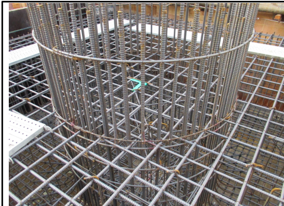
P2 기초 시공 상태 점검
