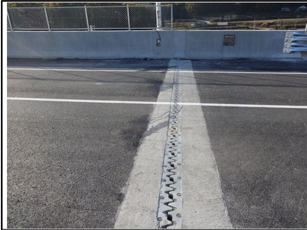
신축이음 A1 전경
